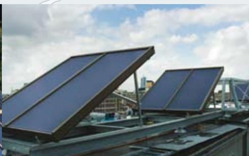
Коллектор, установленный на крыше
